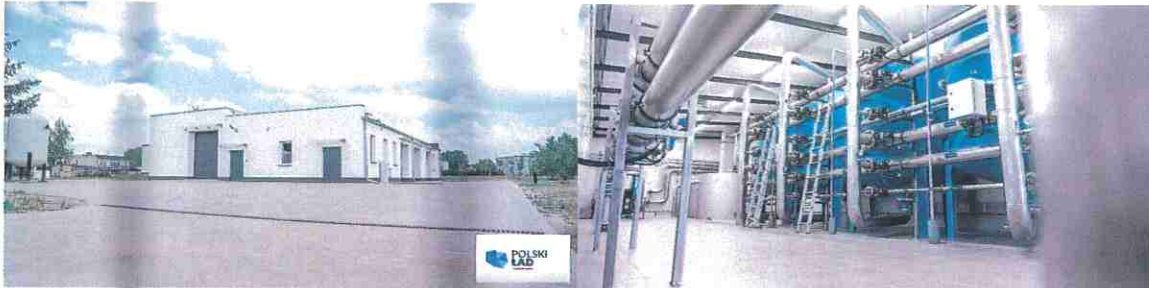
Budynek Stacji Uzdatniania Wody ul. Rejmonta 1, 64-360 Zbąszyń - po modernizacji.
