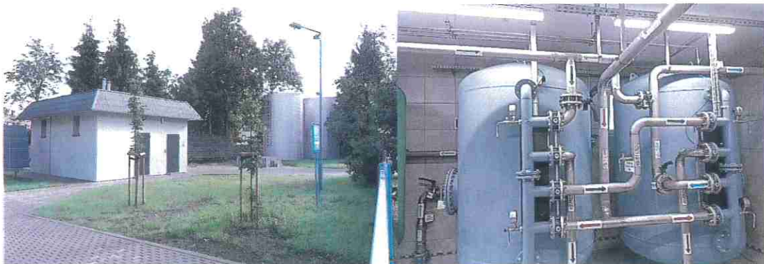
Budynek Stacji Uzdatniania Wody w Sątopach ul. Kościelna 17, 64-300 Nowy Tomyśl – po modernizacji.
