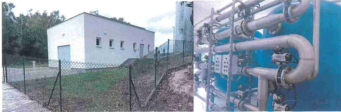
Nowo wybudowany budynek Stacji Uzdatniania Wody we Władysławowie.
