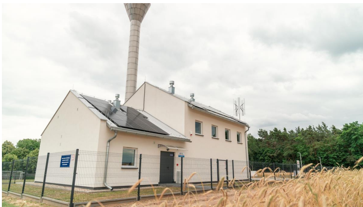
Rysunek 2 Nowo wybudowana stacja uzdatniania wody w Nowej Wsi Zbąskiej.
