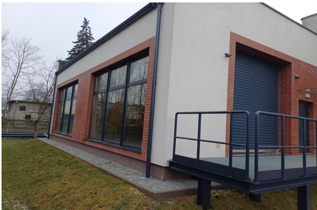
Rysunek 1 Budynek dobudowany do stacji uzdatniania wody w Nowym Tomyślu.
